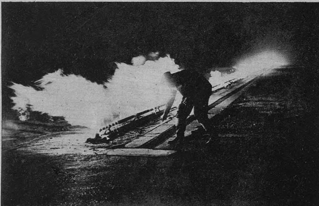
LUZ EN LA NIEBLA. —No se trata del título de una película, sino de los positivos resultados obtenidos en el aeródromo inglés de Blackbuses, donde un empleado, por el sistema «Fido», dispersa la niebla de los alrededores. Este sistema ilumina eficazmente el aeropuerto.—(Foto Keystone.)
