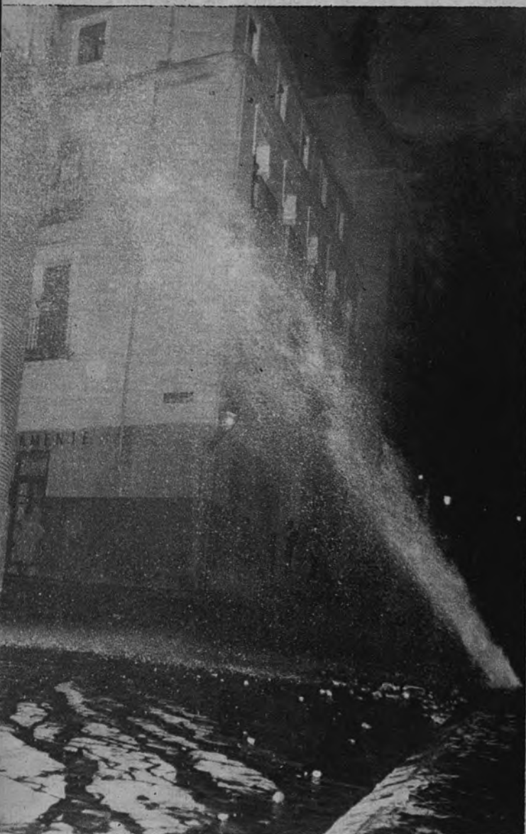
DUCHA EN LA CALLE DE LA ARGANZUELA. — Una cañería reventó en la calle de la Arganzuela, produciendo esta especie de «géiser» castizo, que, entre otras cosas, demuestra la vejez de las instalaciones subterráneas madrileñas para la conducción del agua. (Foto Gama.)
