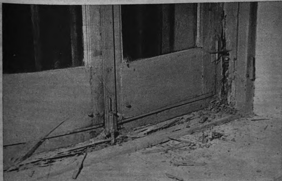
Ventana de la Universidad de Madrid (San Bernardo). Los marcos de puertas y ventanas acusan fácilmente la presencia de la hormiga, que deja sólo una ligerísima capa exterior sin atacar para protegerse del aire y la luz. Un cuchillo entra por la madera igual que por una tarta. Frecuentemente basta la presión del dedo para que ceda la capa superficial y quede visible la caverna excavada
