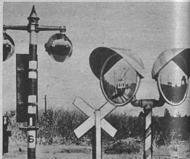
PASO SIN GUARDA. —Para evitar los accidentes en los pasos a nivel sin guarda, los ferrocarriles japoneses han adaptado este tipo de espejos reflectores que señalan la proximidad de los trenes.—(Foto Cifra.)
