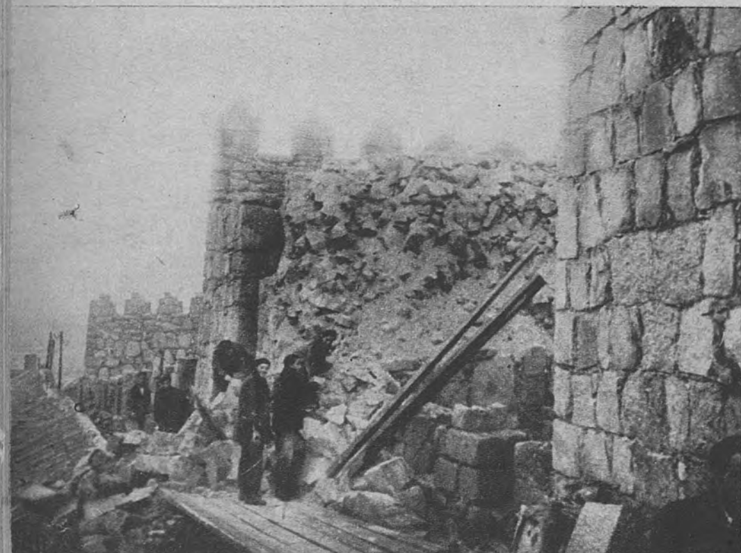
HUNDIMIENTO EN LAS MURALLAS DE AVILA. —A causa del deshielo, se produjo el derrumbamiento del lienzo interior de la Puerta de San Vicente, en las murallas de Avila. El hundimiento se produjo de madrugada
