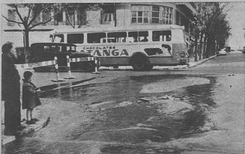
PRINCIPIO DE «SOCAVON». En la calle de Lista, esquina a la de Hermanos Miralles, se ha producido un escape de agua con síntomas progresivos de hundimiento del suelo, género «socavonis matritensis». (Foto Contreras.)
