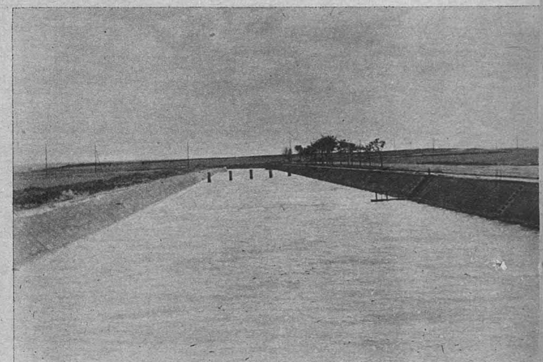
El canal de Monegros en su primer tramo, desde el pantano de La Sotonera hasta el acueducto de Tardienta. Tiene una capacidad de 90 metros cúbicos por segundo
