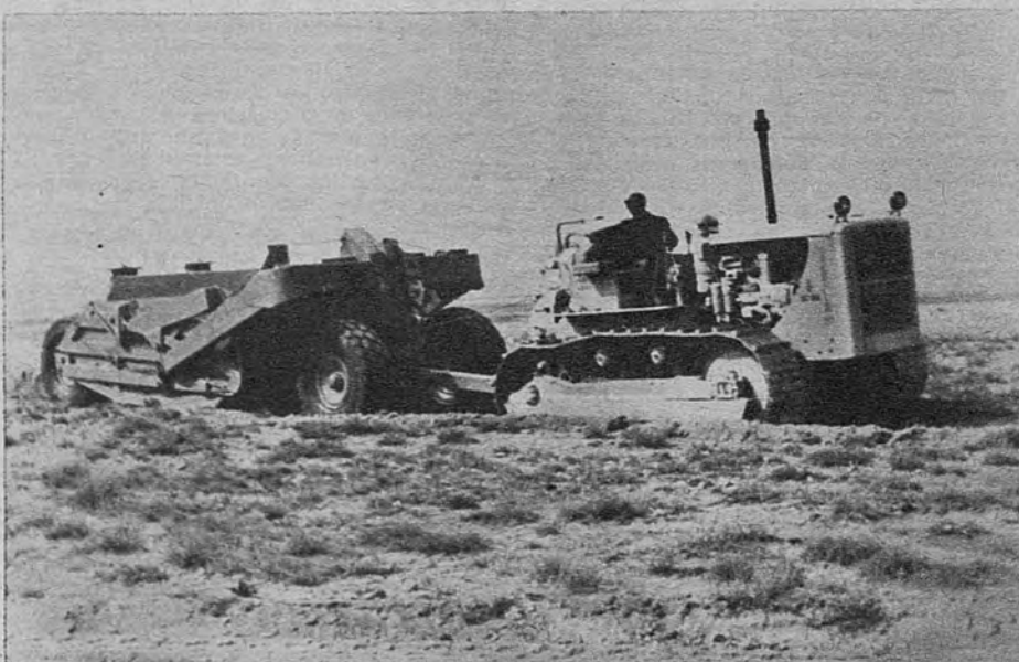
La nivelación de los terrenos en que ha de efectuarse la transformación no es obra fácil y sencilla. Requiere un material potentísimo y, especialmente, un personal técnico experto y preparado. He aquí un tractor con su trailla iniciando el trabajo en uno de los sectores monegrinos
