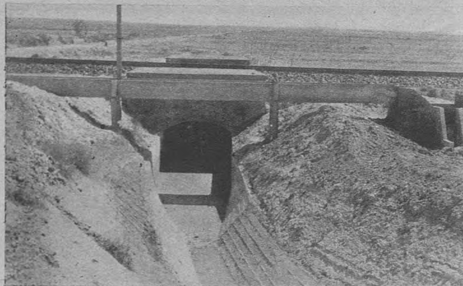
Desagüe bajo el ferrocarril, en el primer tramo del canal de Monegros. Toda la zona, en realidad, está jalonada de obras como la presente
