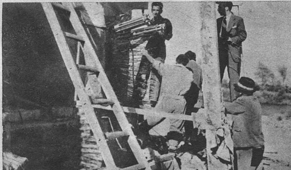
El tensado de la armadura se hizo mediante gatos hidráulicos especiales para este tipo de maniobra, que han sido inventados y contruidos en España. El tensado es tan perfecto que los cables no pierden nada absolutamente de la tensión a que fueron sometidos
