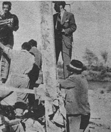
El tensado de la armadura se hizo mediante gatos hidráulicos especiales para este tipo de maniobra, que han sido inventados y contruidos en España. El tensado es tan perfecto que los cables no pierden nada absolutamente de la tensión a que fueron sometidos
