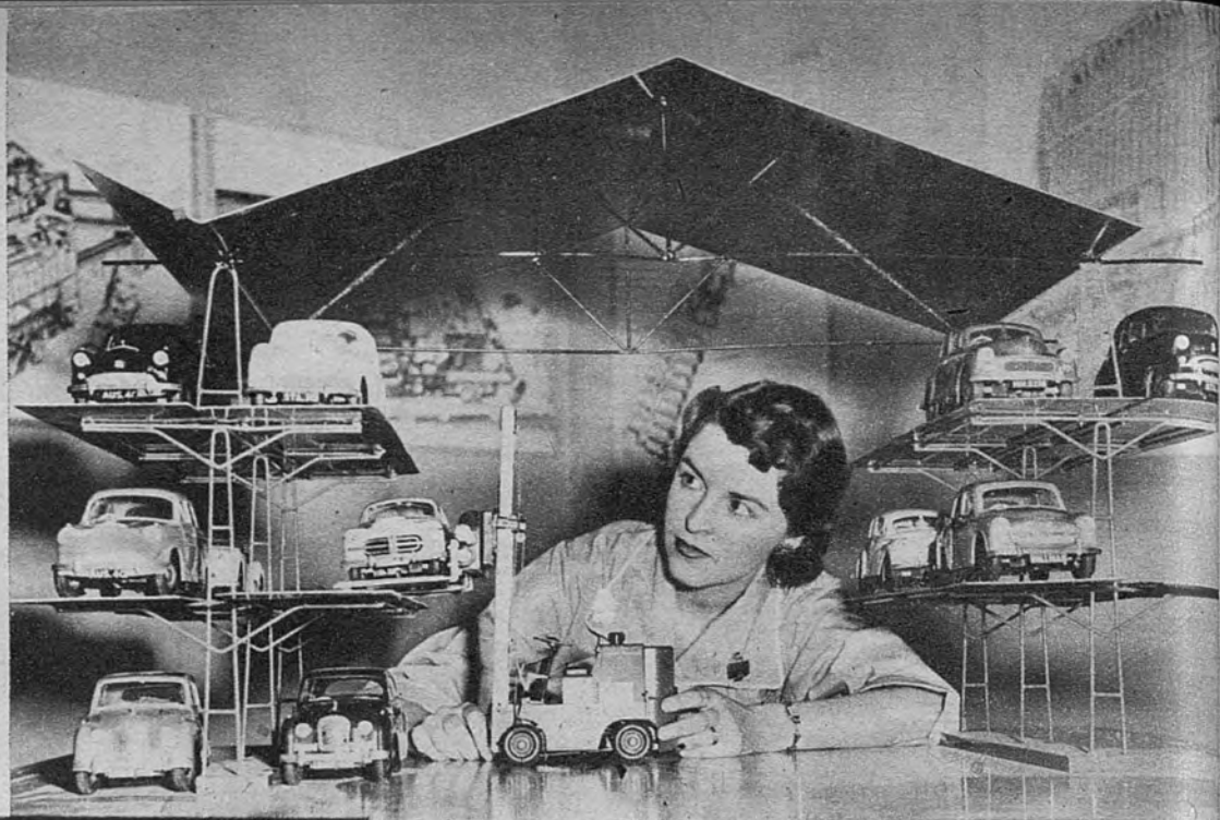
EN SU LUGAR DESCANSEN. —El problema del estacionamiento sigue siendo, por paradoja, el más grave de la circulación. En Earls Court se presenta este modelo de parque de tres pisos, donde los coches son izados por medio de una grúa-ascensor.—(Foto Keystone-Nemes.)
