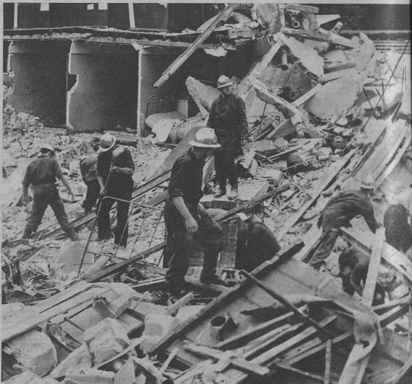
HUNDIMIENTO EN SAINT DENNIS. —En el hundimiento de una casa de vecinos de Saint Dennis resultaron heridos de mayor o menor gravedad doce de los cuarenta y tres inquilinos. El hundimiento se produjo en el momento en que se realizaban trabajos de restauración de la estructura del edificio, cuyo estado de ruina no había sido declarado. En la fotografía aparecen los bomberos en el curso de los trabajos de salvamento de los inquilinos. (Foto Keystone.)
