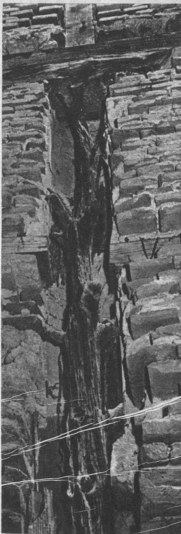
Los destrozos ocasionados por las termitas en la casa de la calle de San Bernardo, que aparece en la página anterior, se nos ofrecen con más detalle en estas dos secciones de la pared medianera, en las que podemos ver el estado del entramado de madera y una de las vigas reducida a la mínima expresión
