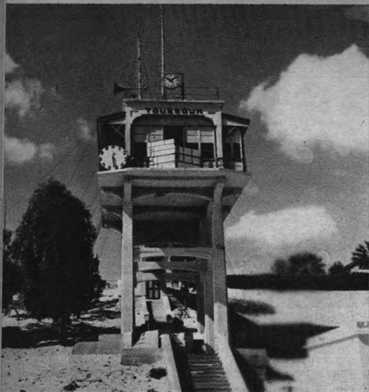
LOS PUESTOS DE SEÑALES. —El recorrido del Canal constituye un mecanismo delicado y preciso. Este es el puesto de señales de Toussom, entre Ismailia y Port Tewfik. Existen once a todo lo largo de la ruta, con objeto de regular la navegación. Los barcos que forman cada convoy deben concentrarse en Port Said y Suez para formar el convoy respectivo, que sale a horas precisas con el fin de cruzarse también de acuerdo con un horario rigurosísimo
