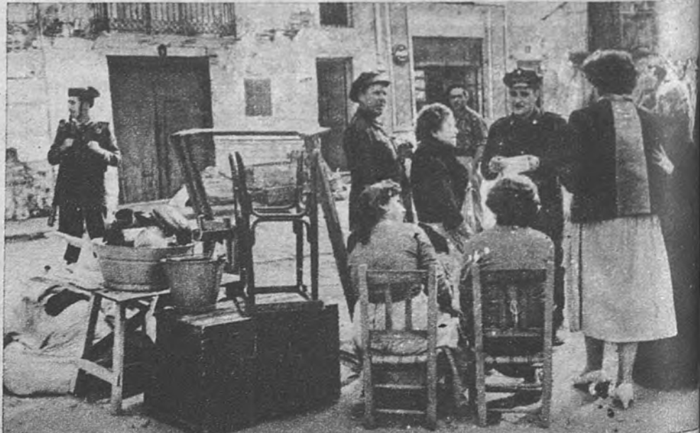
HUNDIMIENTO EN VALENCIA. —Cinco muertos y varios heridos han resultado del hundimiento de una casa en Valencia. Estas son mujeres de las familias que sufrieron las consecuencias del derrumbamiento en la calle de J. J. Sister. (F. Jordán.)
