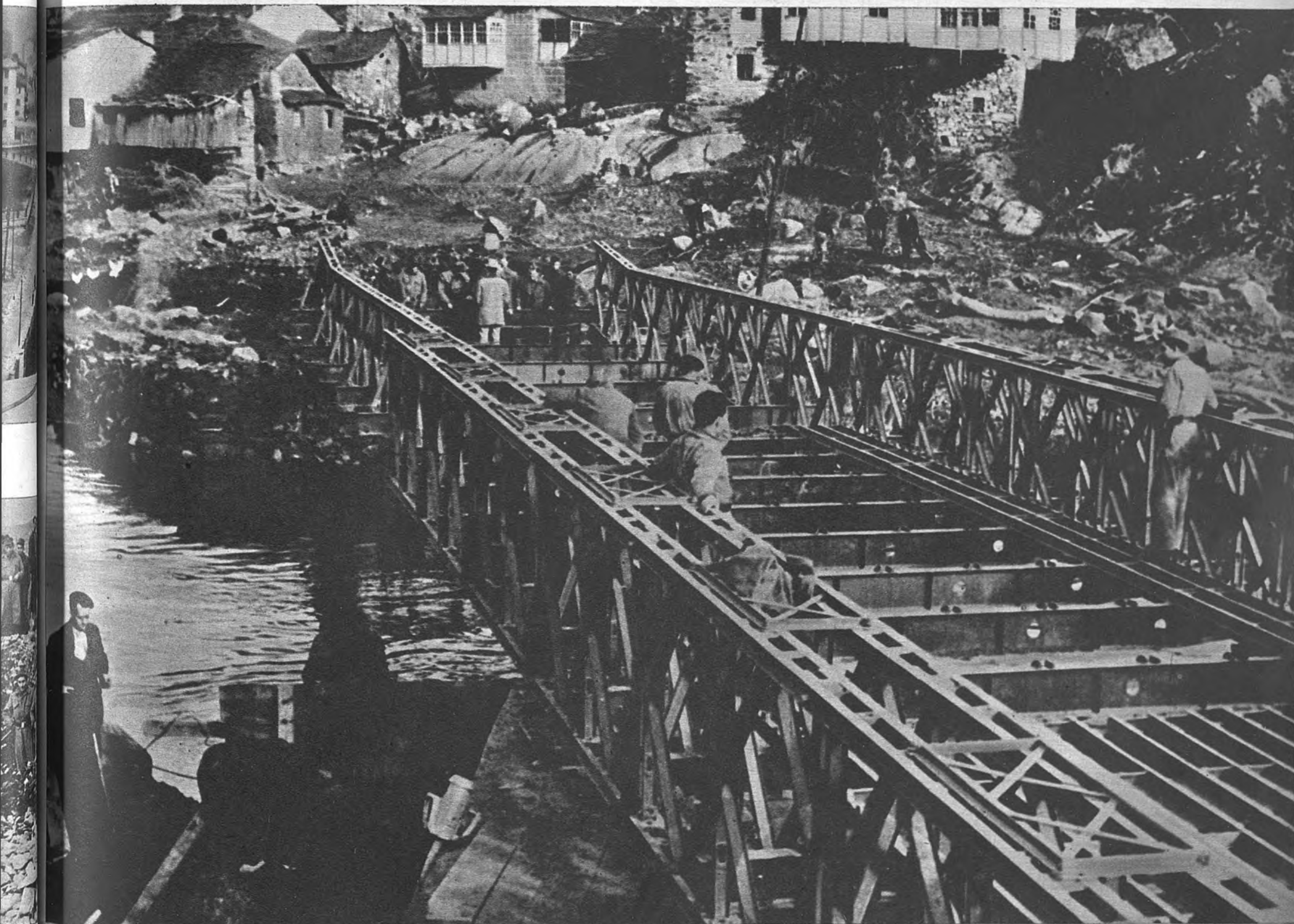
continúe en el que fué escenario del drama. A la izquierda, máquinas explanadoras entran en acción acondicionando los terrenos y accesos sobre los que se construye el nuevo puente metálico, y a la derecha, una perspectiva de éste que, con capacidad para soportar treinta toneladas, sustituye al que se llevó la riada. Los zapadores del Séptimo Cuerpo de Ejército trabajan incansablemente en su instalación que está ya, como se ve, muy avanzada. — (Fotografías de Cifra.)
