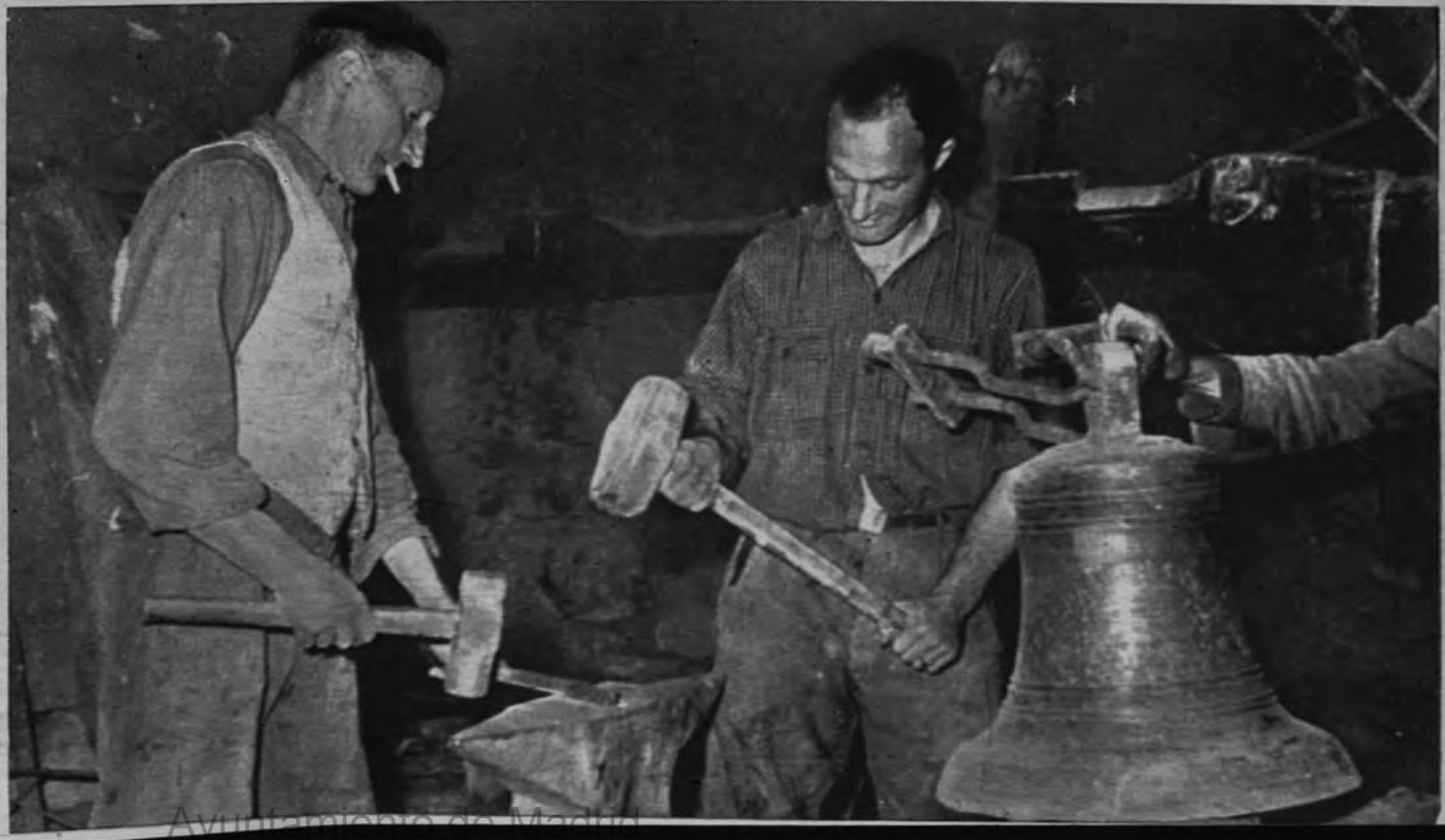
DONDE FUNDEN LAS CAMPANAS. —En la provincia de Santander, la Merindad de Trasmiera es famosa como tierra de campaneros que realizan su oficio con arreglo a antiquísimos procedimientos transmitidos de generación en generación. La arcilla, el estiércol, el sebo y la cera son elementos primordiales para el buen resultado. La chimenea del horno está construída aprovechando un cubo solariego en el que figura un bello escudo con un roble, escudo adoptado como marca de fábrica, como puede verse arriba. Abajo, dos momentos del duro y delicado trabajo realizado en una fundición de Vierna. — (Fotografías de Fiel.)
