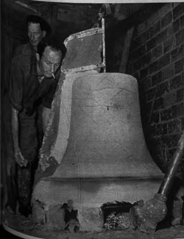
DONDE FUNDEN LAS CAMPANAS. —En la provincia de Santander, la Merindad de Trasmiera es famosa como tierra de campaneros que realizan su oficio con arreglo a antiquísimos procedimientos transmitidos de generación en generación. La arcilla, el estiércol, el sebo y la cera son elementos primordiales para el buen resultado. La chimenea del horno está construída aprovechando un cubo solariego en el que figura un bello escudo con un roble, escudo adoptado como marca de fábrica, como puede verse arriba. Abajo, dos momentos del duro y delicado trabajo realizado en una fundición de Vierna. — (Fotografías de Fiel.)
