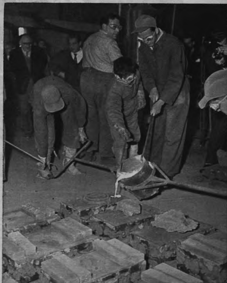
un cubilote modernísimo al que puede sacársele un rendimiento de media tonelada a la hora y el cual viene a servir para enseñar el recorrido de una colada de hierro, de la que sucesivamente podrán observar las principales fases normales hasta la obtención de las primeras piezas de ensayo. Los alumnos fueron ejecutores del breve proceso.—(Texto de CACHO-DALDA. Fotografías Mamegán.)
