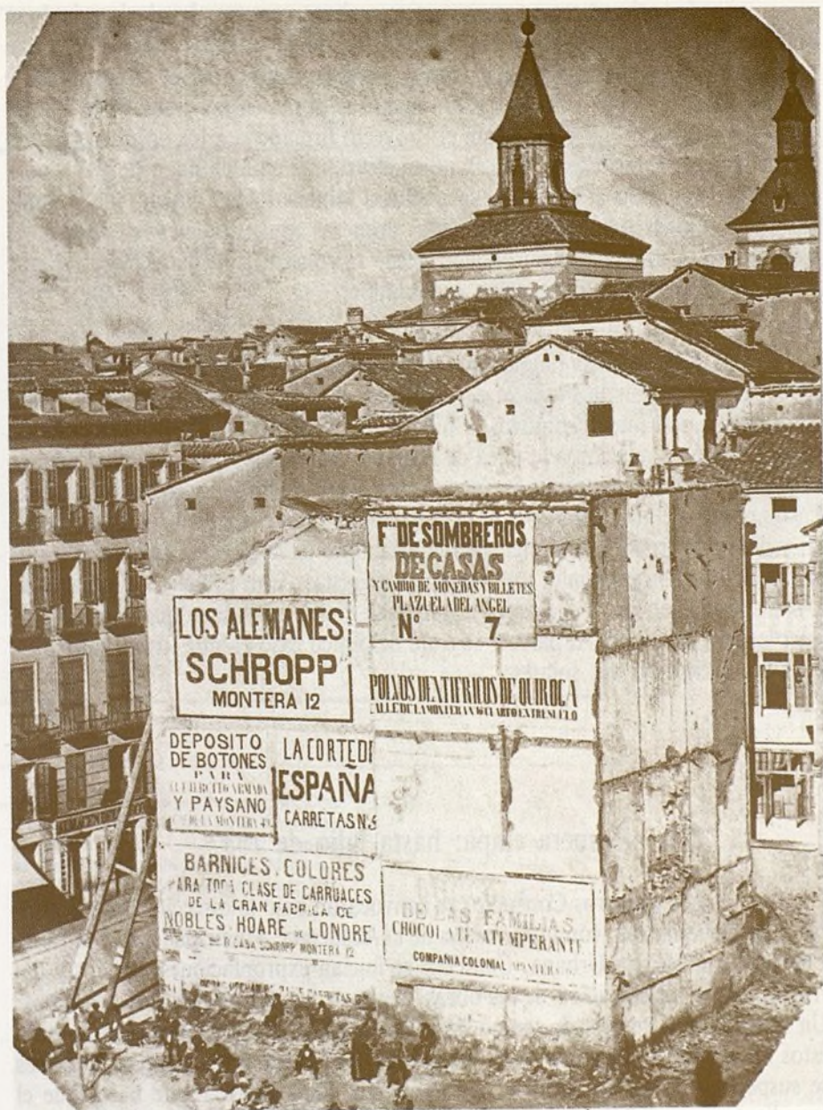
9.—Aspecto de la Puerta del Sol con los derribos ya iniciados. M.M. 3031, h. 1857.
