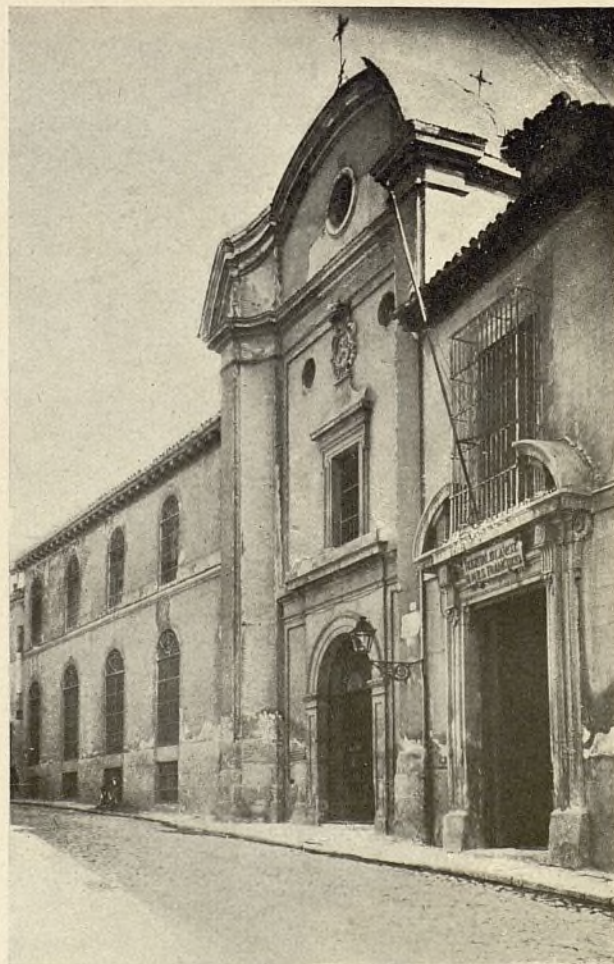
Hospital de la Orden Tercera
