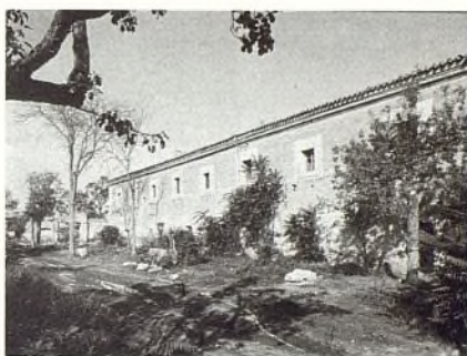
Edificio de celdas
