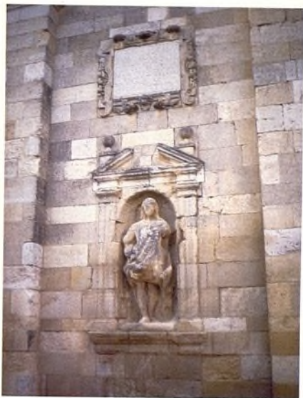
Detalle de un lateral de la portada principal
