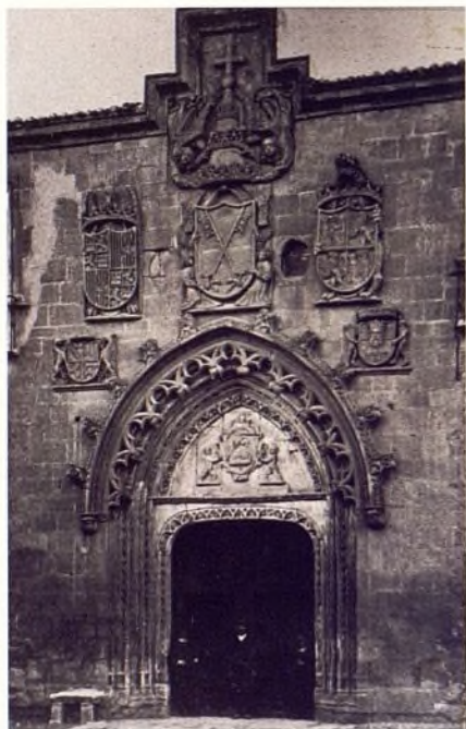
Fachada del Hospital
