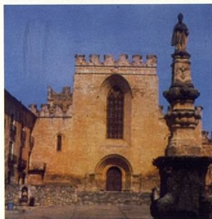
Vista de la fachada de la iglesia
