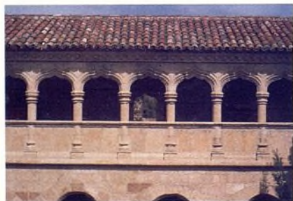
Claustro de la Enfermería, donde estuvo ubicada la botica
