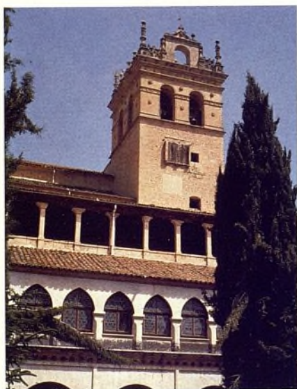
Campanario visto desde el claustro Procesional o Principal
