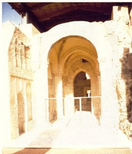
Restos de la capilla de San Mancio
