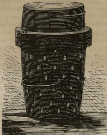
Molde para fundir los proyectiles del sistema Armstrong.
