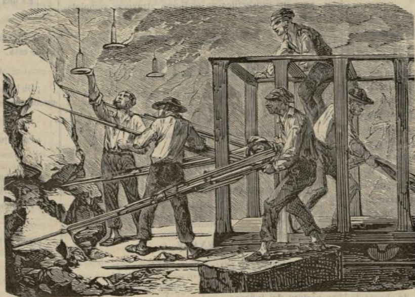
Obreros perforadores en el tunel del Monte-Cenis
