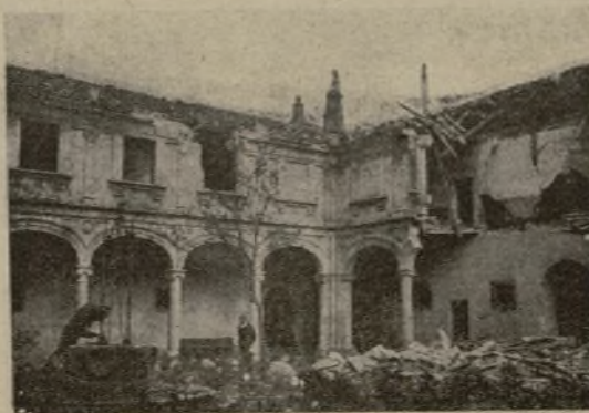
Destrucciones causadas por una bomba en un patio de la Universidad de Alcalá de Henares. Esto es el fascismo: casas arruinadas..., obras de arte destruidas...
