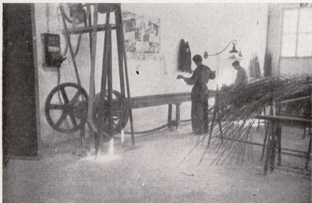
Banco de estiraje para calibrar el material.
