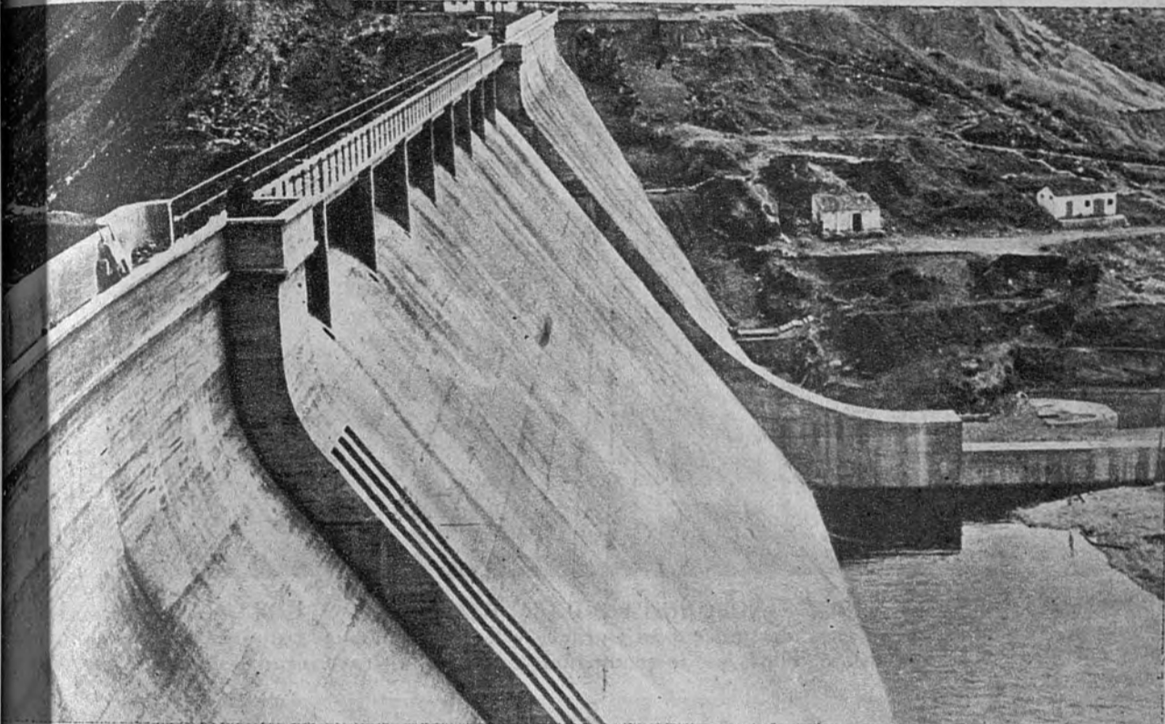
PANTANO DEL ESTRECHO DE PEÑARROYA. —Hoy sábado, el Ministro de Obras Públicas inaugurará el pantano del Estrecho de Peñarroya, situado en el Alto Guadiana. La nueva obra tiene más de cuarenta y cinco millones de metros cúbicos de capacidad. Una vista de la presa
