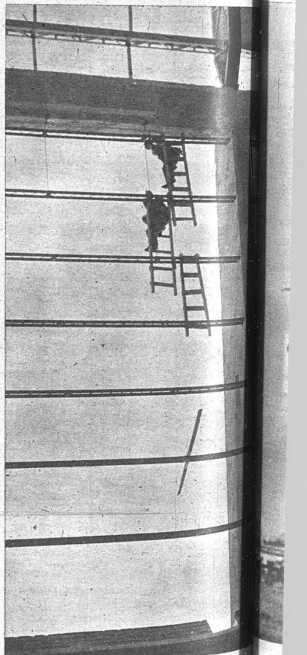
PALACIO DE LOS DEPORTES. —Un aspecto general y dos parciales detalles de las obras efectuadas en el Palacio de los Deportes. La trama metálica de la gran cubierta ha sido ya instalada y la tribuna y graderios están a punto de terminarse, así como el vaciado del Palacio. Sobre la antigua plaza de toros, en el viejo solar de las verónicas, Madrid alza el Palacio de los Deportes es que hace tiempo venían reclamando las necesidades actuales.—(Alcoba.)
