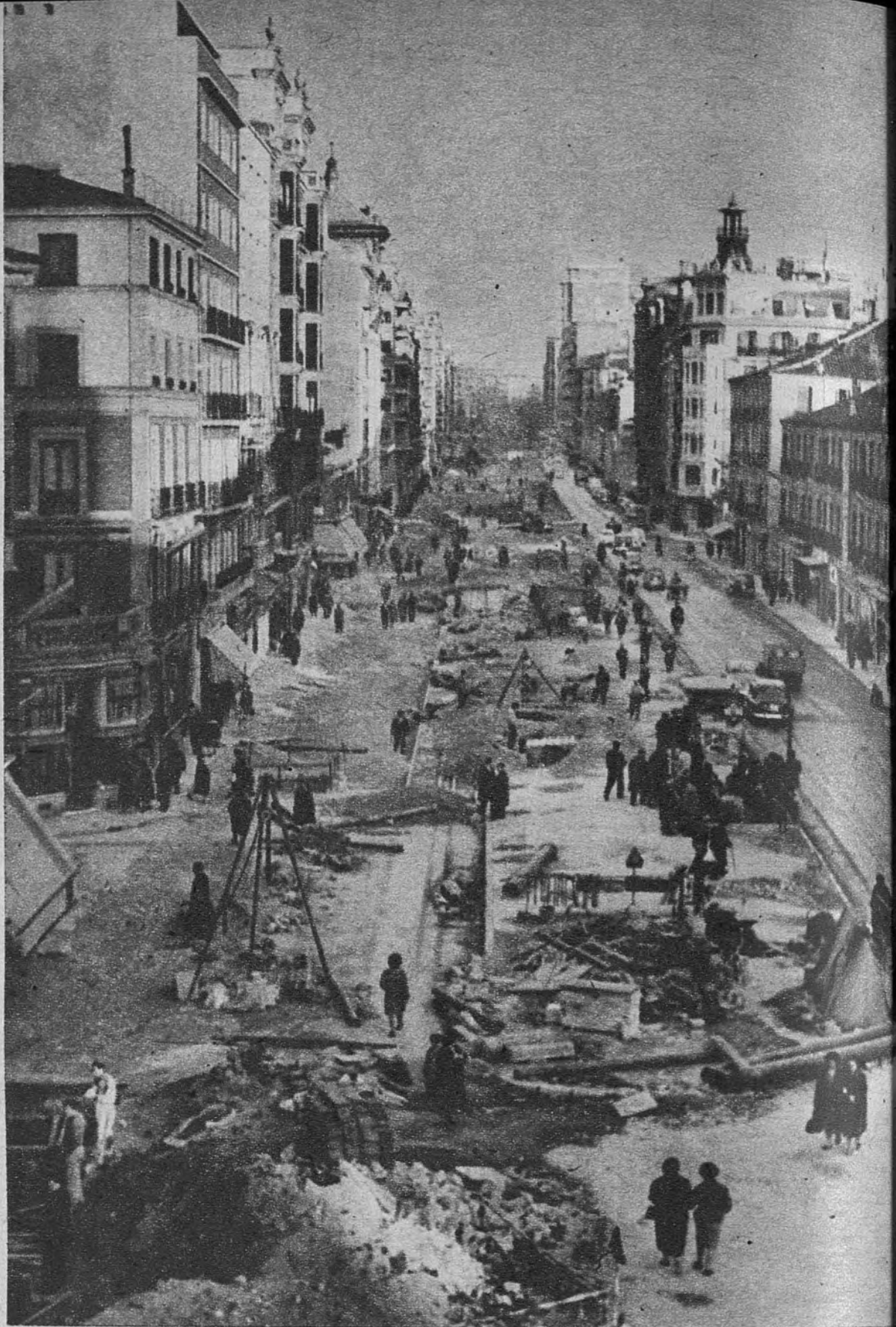
NUEVO PERFIL DE LOS BULEVARES. —Aunque con menos prisa de lo que los madrileños desearíamos, las obras de reforma de los bulevares siguen adelante. Aquí tienen ustedes algunas muestras del trabajo de pavimentación, un primer plano de los árboles supervivientes en Alberto Aguilera y el levantamiento de las vías. A la derecha, una perspectiva desde Argüelles de la nueva vía en trance de profundo cambio.—(Fotos Antonio Alcoba.)
