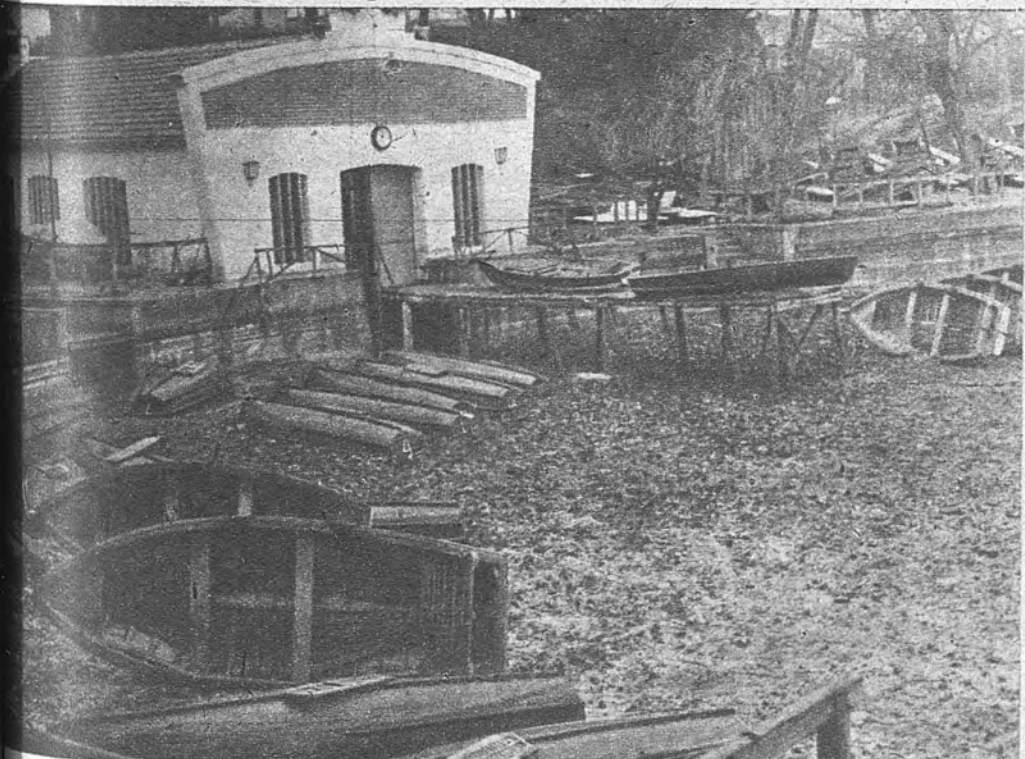
EL ESTANQUE DE LA CASA DE CAMPO. —El Ayuntamiento de Madrid realiza obras de saneamiento en el estanque de la Casa de Campo. Gran cantidad de agua ha sido desalojada y este es el aspecto del embarcadero
