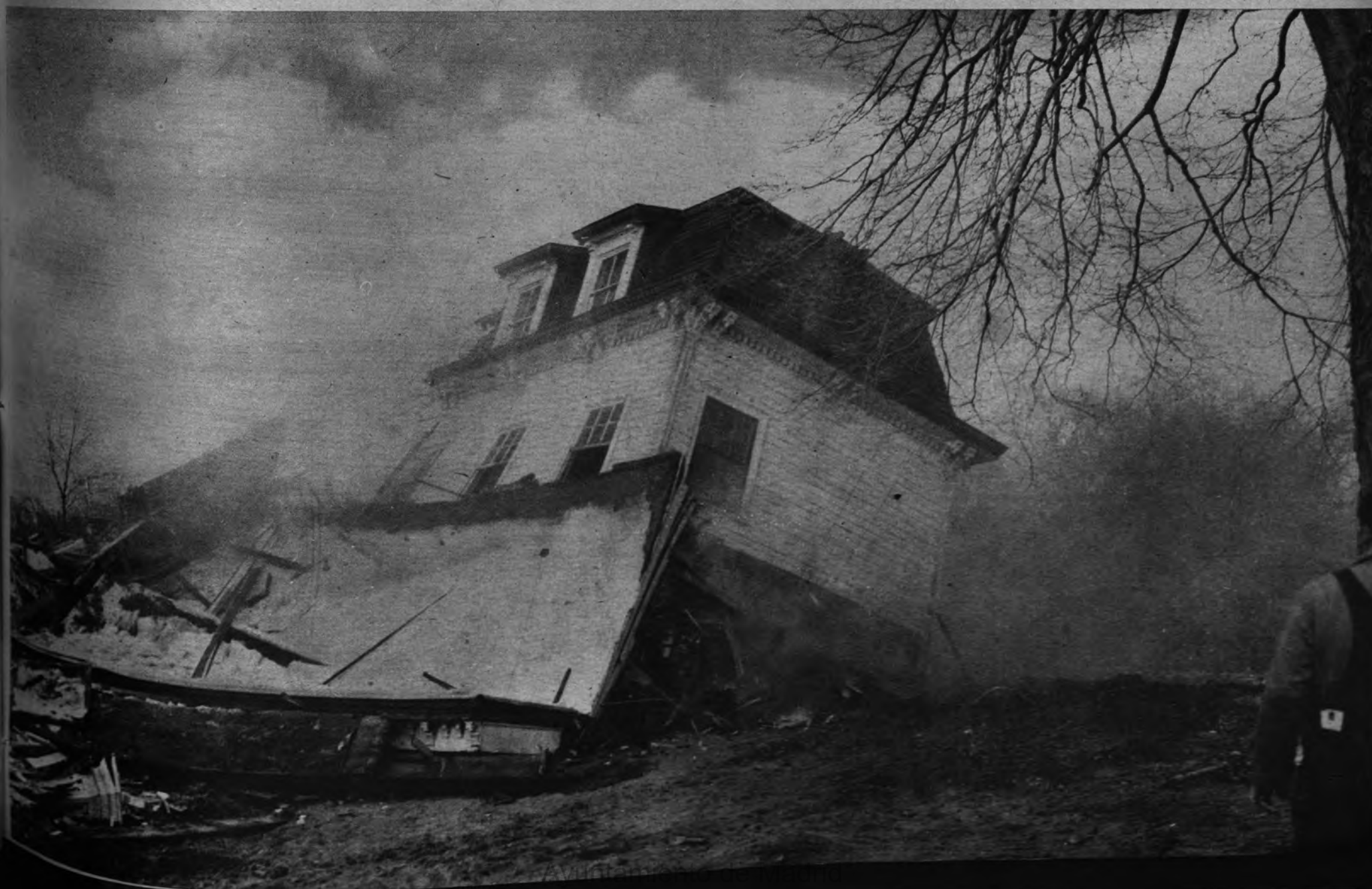
NUEVA TECNICA PARA EL DERRIBO DE CASAS. —Aunque en todas partes lo que hace falta es levantar casas, a veces es inevitable el tener que derruir otras. La técnica le ofrece al hombre para este menester un nuevo procedimiento del que aquí recogemos dos imágenes. Carmen Ottilio, de Patterson, Nueva Jersey, es la inventora. Se trata de utilizar tanques de cuarenta y cinco toneladas. Solamente unas pasadas y todo queda liso como la palma de la mano.—(Foto Cifra.)
