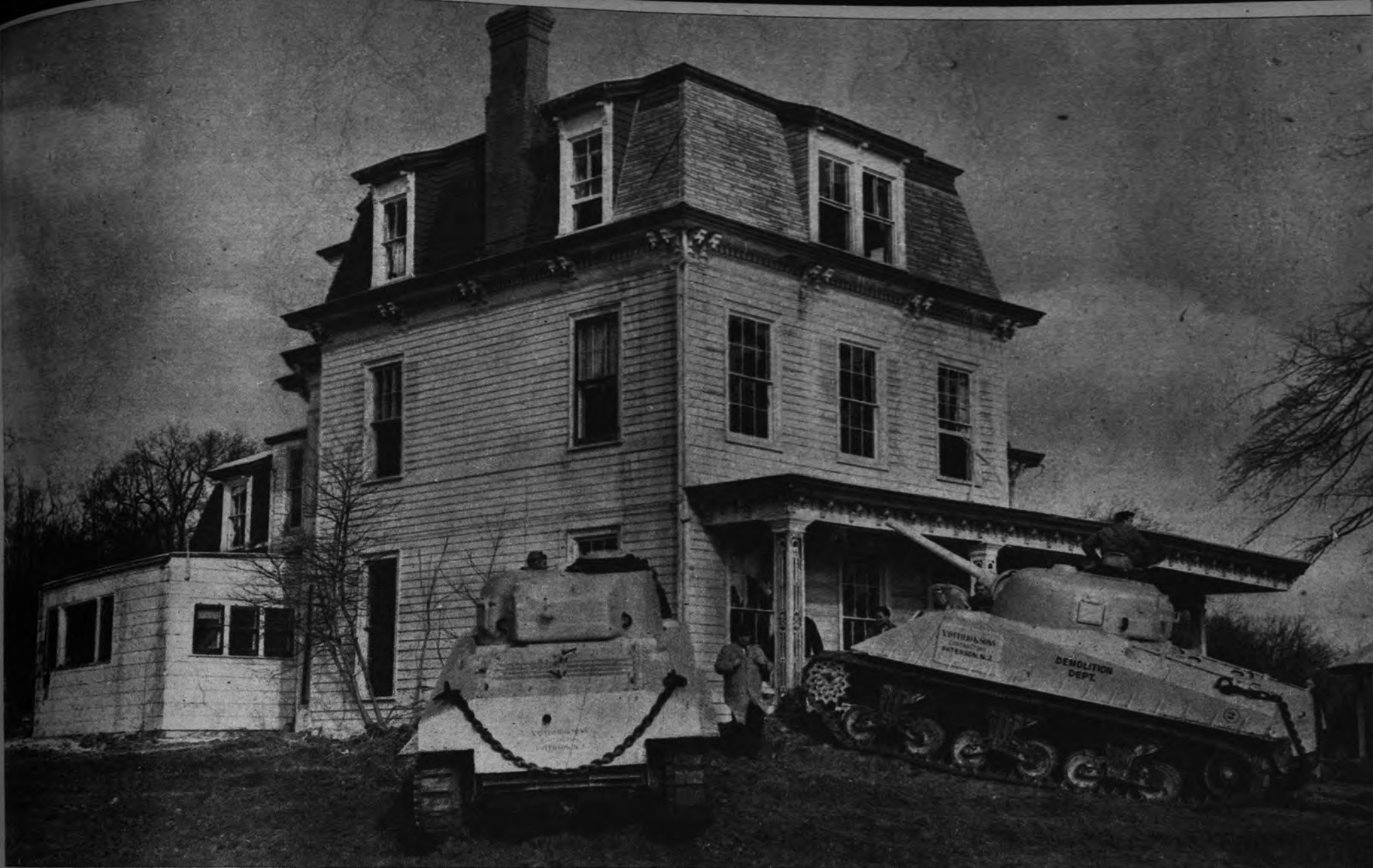
NUEVA TECNICA PARA EL DERRIBO DE CASAS. —Aunque en todas partes lo que hace falta es levantar casas, a veces es inevitable el tener que derruir otras. La técnica le ofrece al hombre para este menester un nuevo procedimiento del que aquí recogemos dos imágenes. Carmen Ottilio, de Patterson, Nueva Jersey, es la inventora. Se trata de utilizar tanques de cuarenta y cinco toneladas. Solamente unas pasadas y todo queda liso como la palma de la mano.—(Foto Cifra.)
