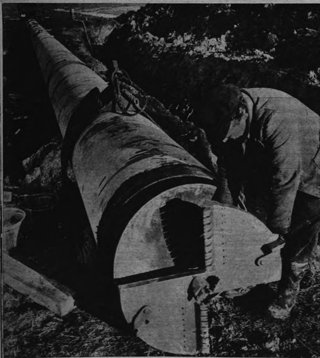
PARA HACER AGUJEROS. —Ejemplo de taladradora gigante que se emplea en la apertura de un túnel para oleoducto en Alemania. Cualquier obstáculo, carretera o vía férrea, es superado por la máquina sin interrumpir el paso. — (Foto Fiel.)
