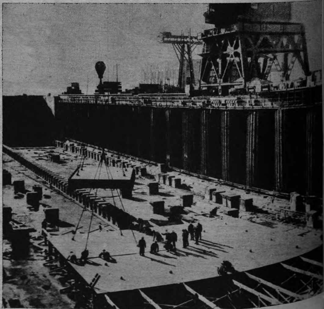
PORTAAVIONES ATOMICO. —En el dique seco de los astilleros de Newport News, Norteamérica, se procede a la colocación de la quilla del primer portaaviones atómico. Dotado de ocho reactores, puede navegar dos años sin repostar.—(Cifra.)
