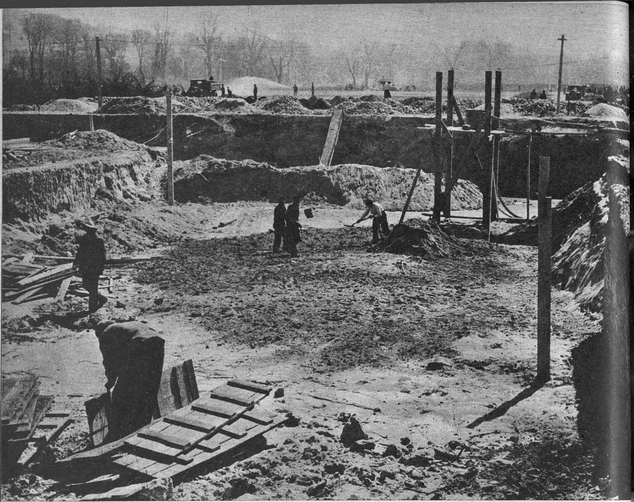
PISCINA OLIMPICA PARA EL PARQUE SINDICAL. —Este es el vaciado de la piscina olímpica de competiciones que actualmente se construye en el Parque Sindical Deportivo de Puerta de Hierro. Unida a ella se construirá también otra monumental, de grandes dimensiones, con zona infantil.—(Fotografías Albergo y Segovia.)
