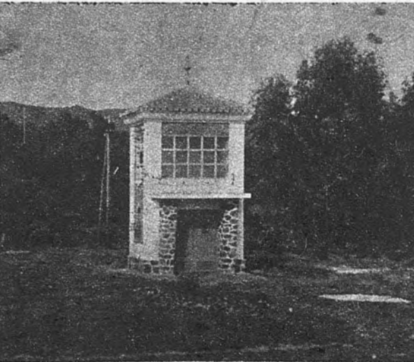
Hasta las estaciones transformadoras de energía eléctrica tienen una belleza original
