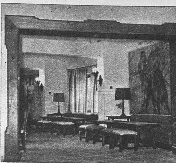
Aspecto parcial de uno de los saloncitos de la Venta de «Las Chapas»
