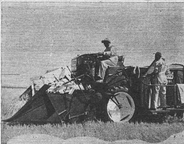
Cosechadora autopropulsada S. A. C. A. Fahr, que se construye en esta factoría sevillana bajo licencia alemana. Sus características más principales son: ANCHO DE CORTE, 1,80 metros; MOTOR A GASOLINA, 37 H. P.; RENDIMIENTO, 1.000-1.200 kg.-hora
