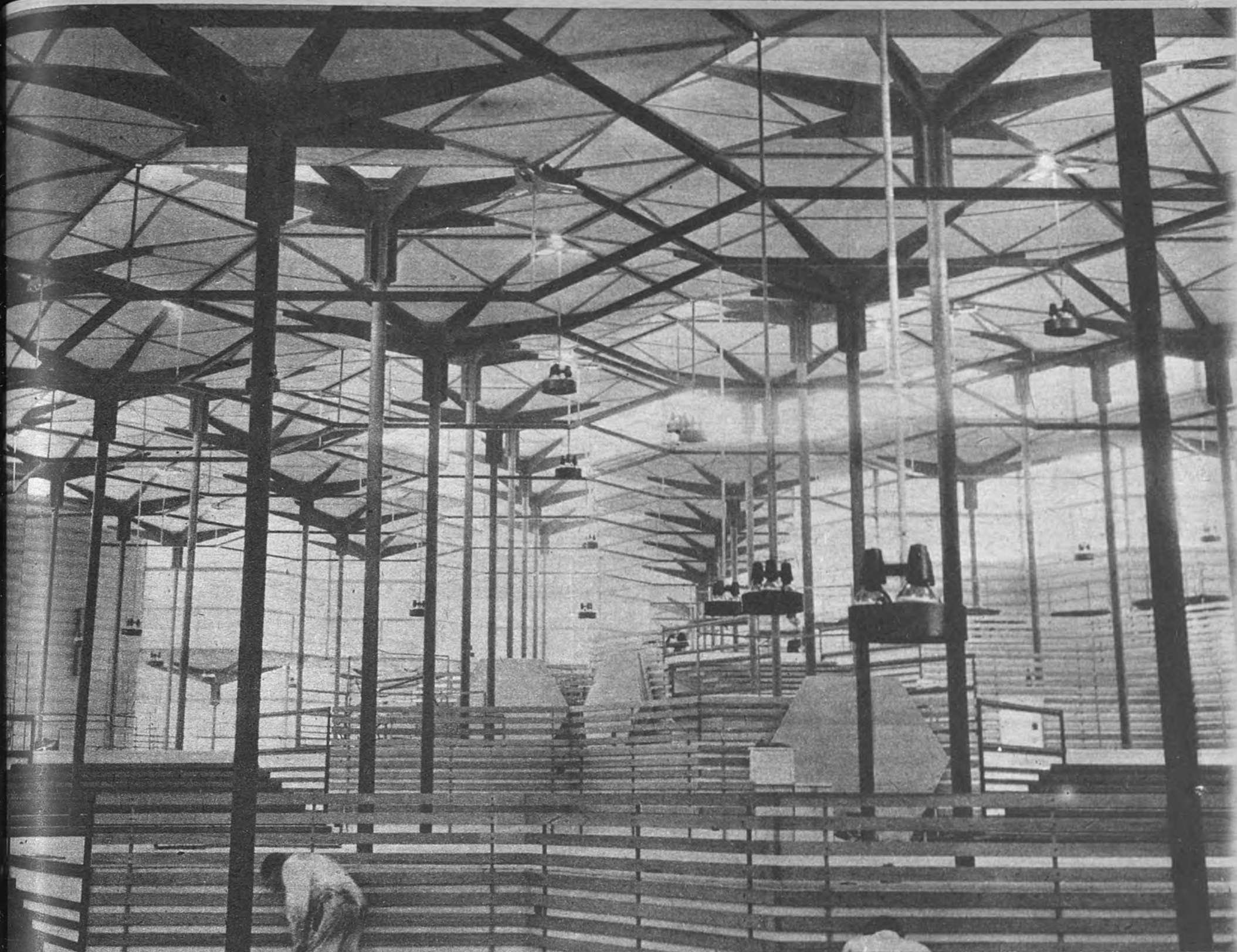
PABELLON ESPAÑOL. —Una perspectiva interior del pabellón español en la "Expo" de Bruselas. Su estructura es originalísima. Está constituida por una multitud de sombrillas metálicas, de fácil y rápido ensamblaje, cuyos pilares de sustentación sirven al propio tiempo de desagüe. Muchos arquitectos e ingenieros de la "Expo" han coincidido en señalar el pabellón español como el de máxima originalidad técnica de los que integran el Certamen.—(Fotografía Torremocha.)
