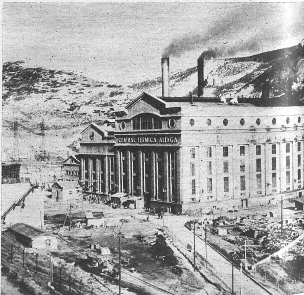
MAS ENERGIA. —En Aliaga, en la provincia de Teruel, funciona una nueva central térmica. Consta de tres grupos generadores, cuya potencia total, a pleno rendimiento, es de cuarenta y siete mil kilovatios. — (Fotografía de Cifra.)
