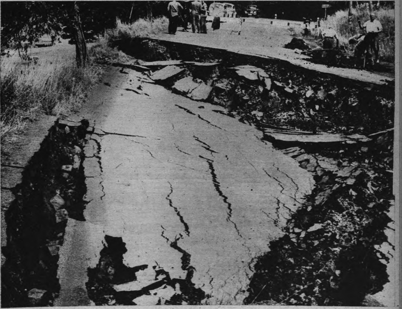
DESPRENDIMIENTO DE TIERRA. —En este estado quedó la carretera que va desde Fulda a Francfort, después del hundimiento de tierras. Los vehículos tendrán que dar una vuelta de cincuenta kilómetros hasta que sea reparada. (Cifra.)
