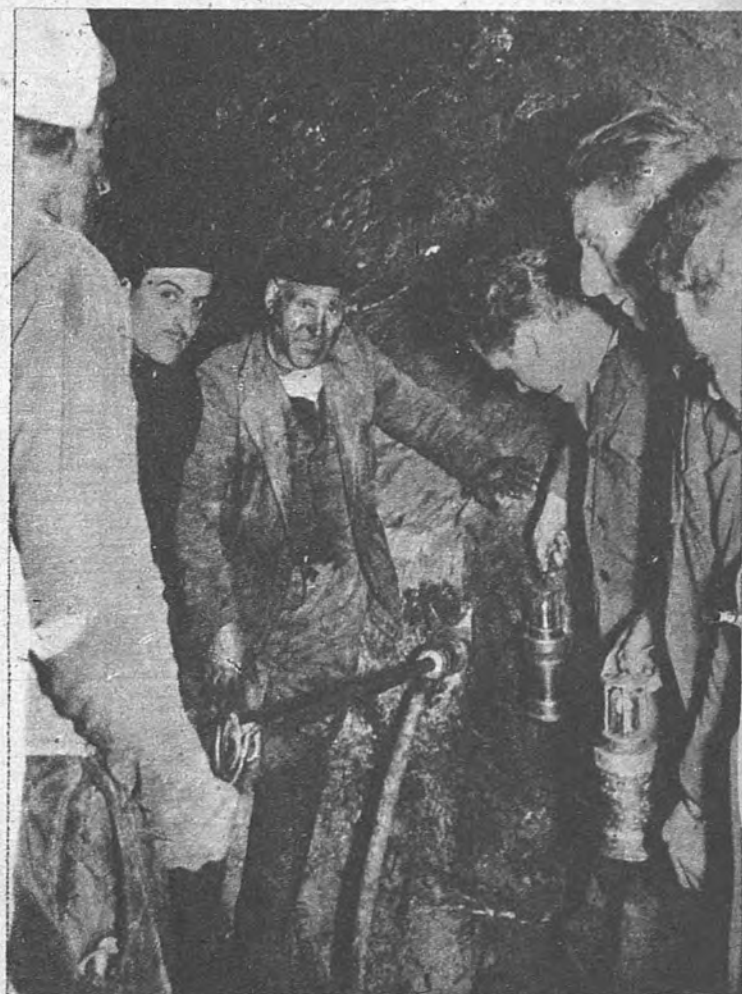
ARMA CONTRA LA SILICOSIS. —En Cervera de Pisuerga se ha probado con éxito, en la mina "Olavide", un aparato que acoplado a los martillos picadores elimina el polvo causante de la silicosis. El aparato es de poco coste y fácil manejo.—(Foto Cifra.)
