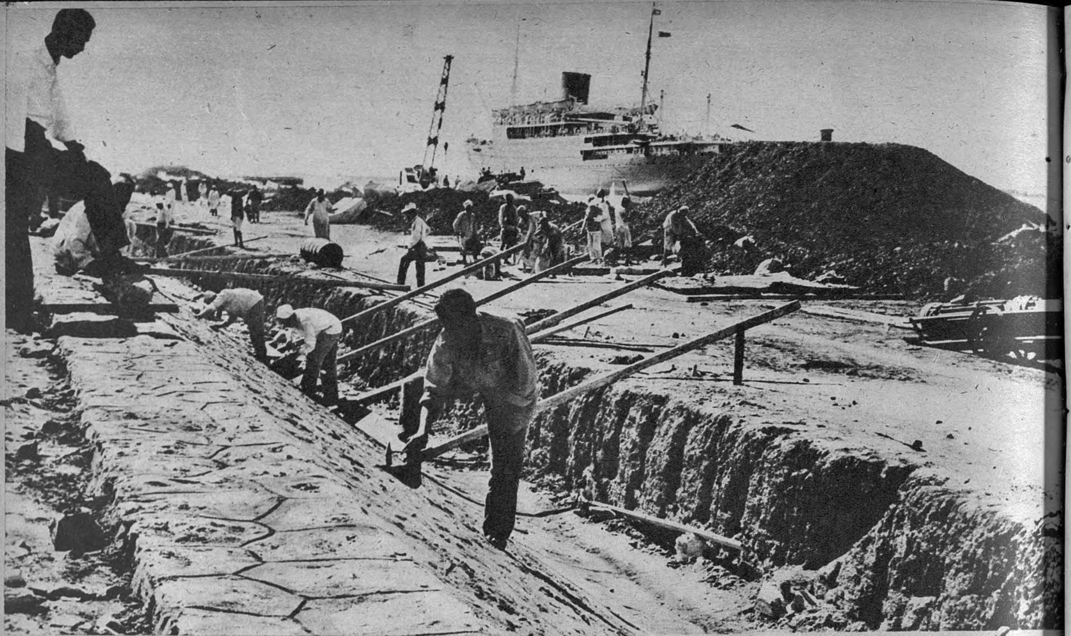
IMPORTANTES REFORMAS EN EL CANAL DE SUEZ. —Ofrecemos esta vista de los trabajos que actualmente se realizan en el canal de Suez, según el "Plan Nasser". El objetivo es aumentar las dimensiones de esta importante vía de comunicación, que ganará 90 centímetros en profundidad y 35 metros de anchura. — (Foto Cifra.)
