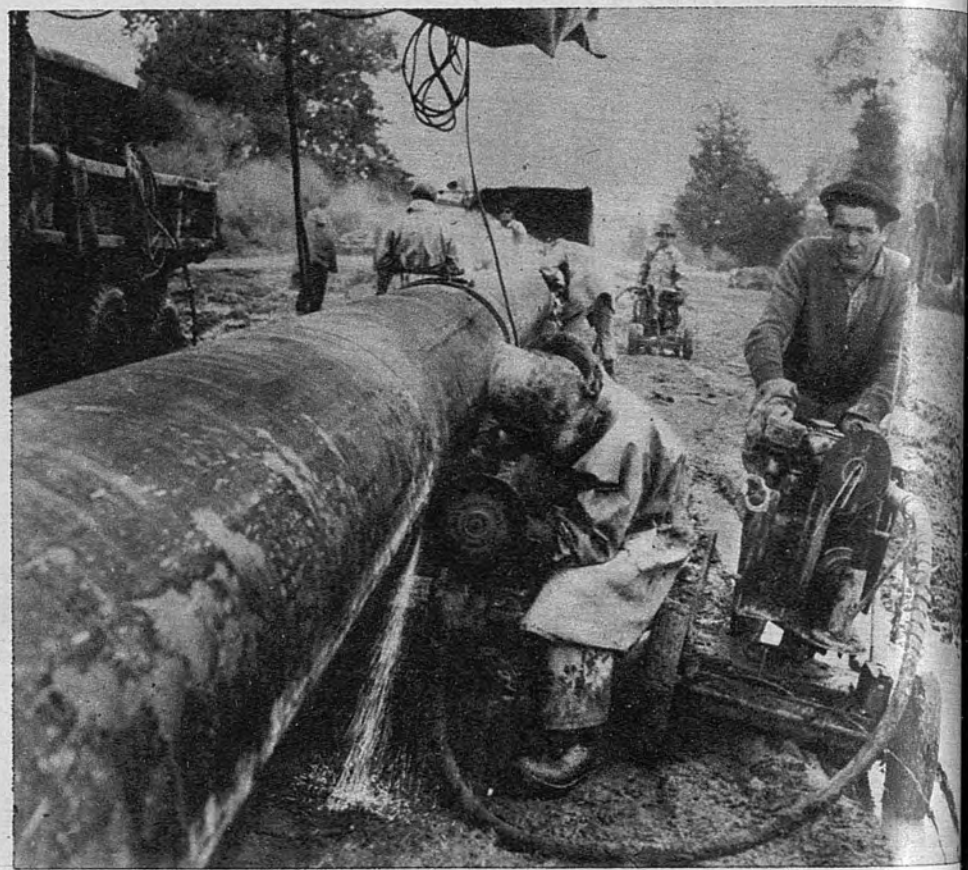
EL GAS, CAMINO DE PARIS. —Angulema es la última ciudad francesa servida por el gas de Lacq. Los trabajos siguen hasta París y aquí vemos el gasoducto que continúa construyéndose a razón de cuatro kilómetros por día.—(K.-Nemes.)
