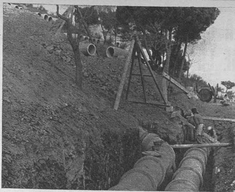
Tuberías de impulsión instaladas por la Sociedad General de Aguas de Barcelona a la salida del depósito de esta entidad en la población de Moncada
