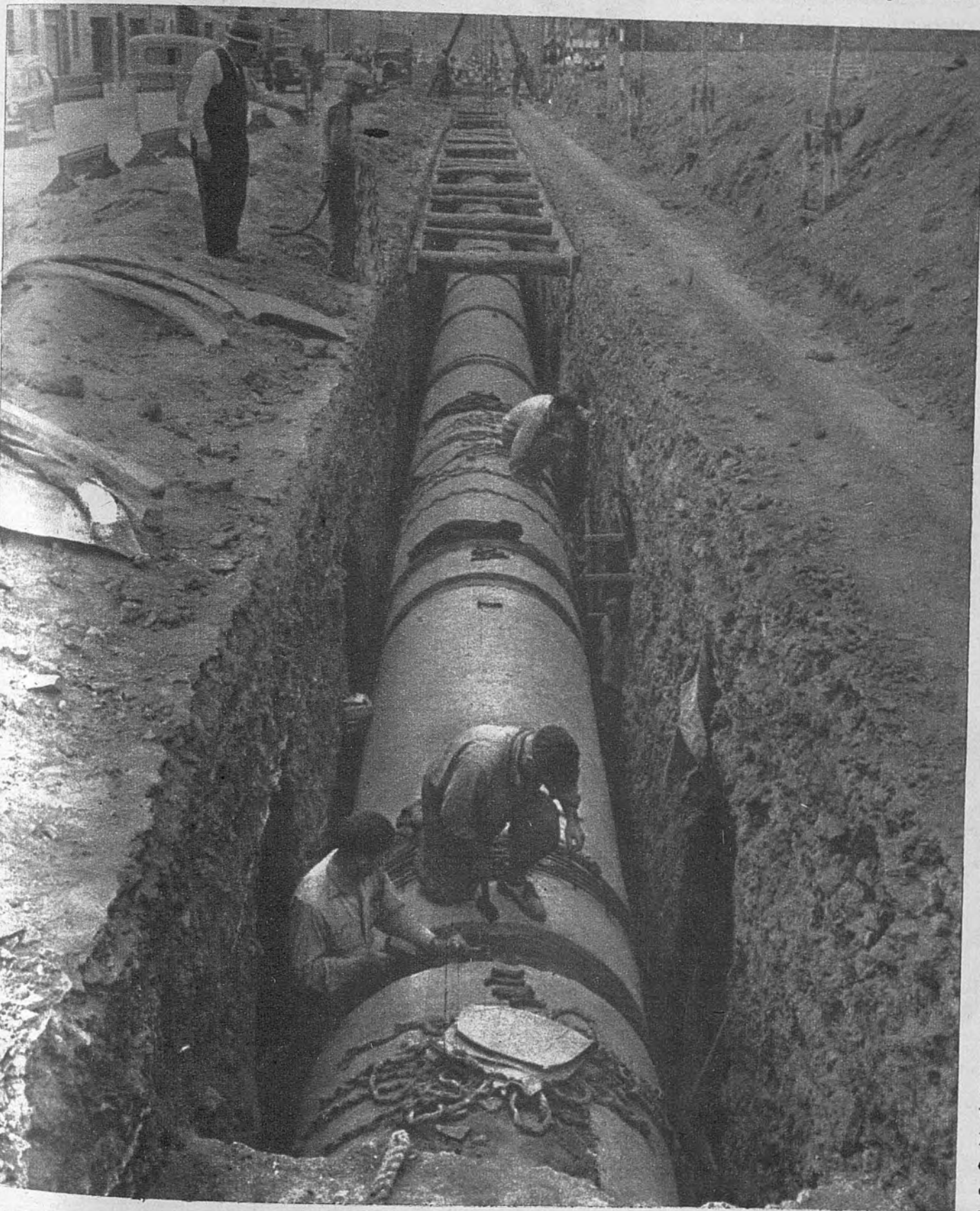
Nueva arteria de 1.25 metros de diámetro, destinada a mejorar la presión de las redes distribuidoras de agua para Barcelona
