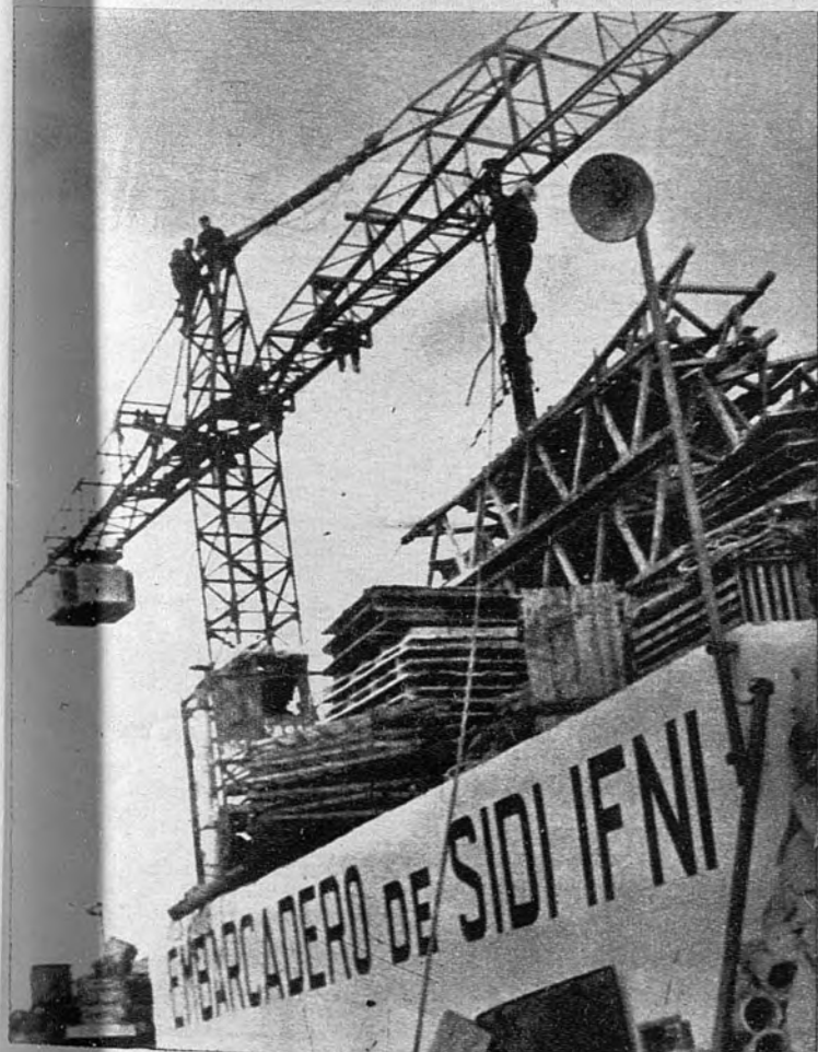
SIDI IFNI, PUERTO DE MAR. —Se están realizando en Ifni las obras de un puerto artificial que se construye para facilitar la llegada de barcos de toda clase de tonelaje a aquella provincia. El puerto consiste en un islote enlazado por medio de un transbordador con la costa natural. Las fotografías que publicamos presentan uno de los bloques de hormigón que se utilizan para las instalaciones y que son trasladados a Sidi Ifni desde Canarias. — (Fotografías de Fiel.)
