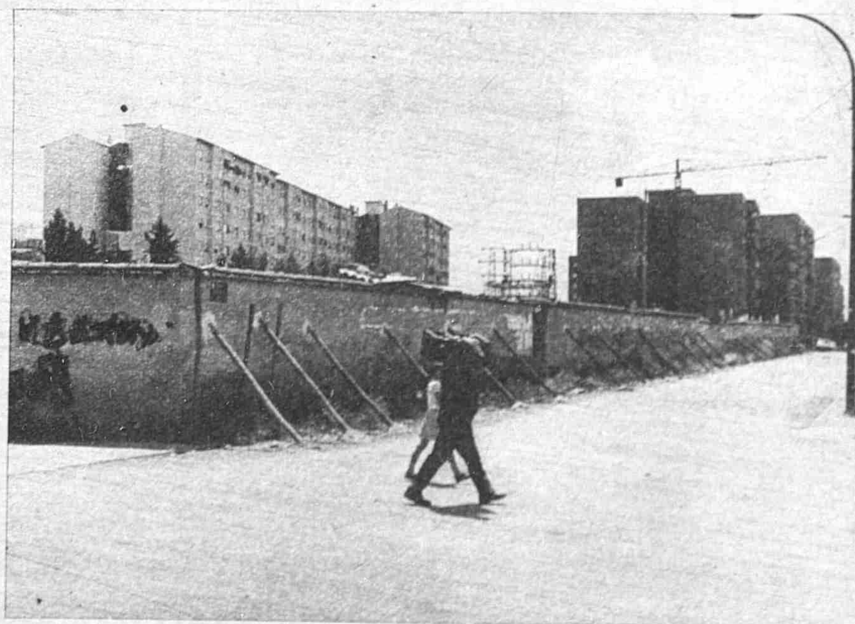
En Móstoles hubo que apuntalar el cementerio antiguo debido a las malas condiciones que reunía
