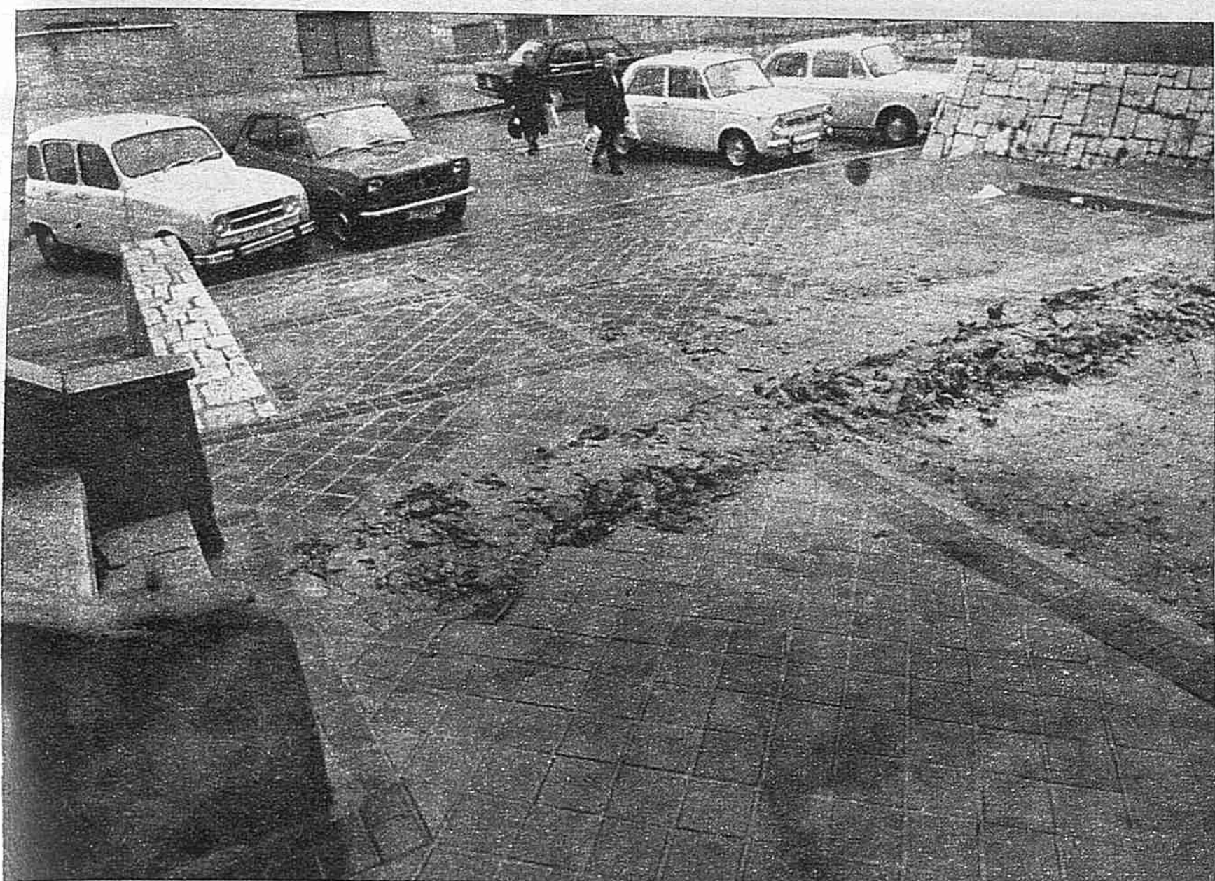
Esa zona que se ve levantada en donde se localiza la avería, supuesta causante del hundimiento
