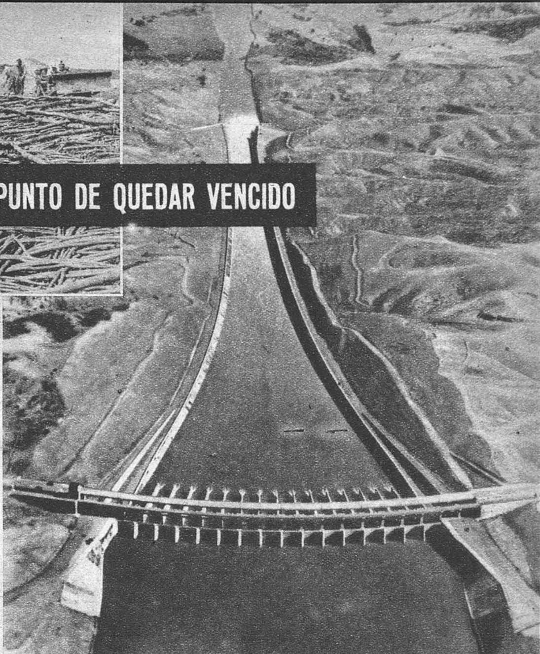
EL ALIVIADERO DE FORT PECK. —Este enorme canal atraviesa una larga extensión del estado de Montana para aliviar la inmensa laguna —con 2.560 kilómetros de costas— que supone en el nuevo sistema de regulación la presa de Fort Peck
