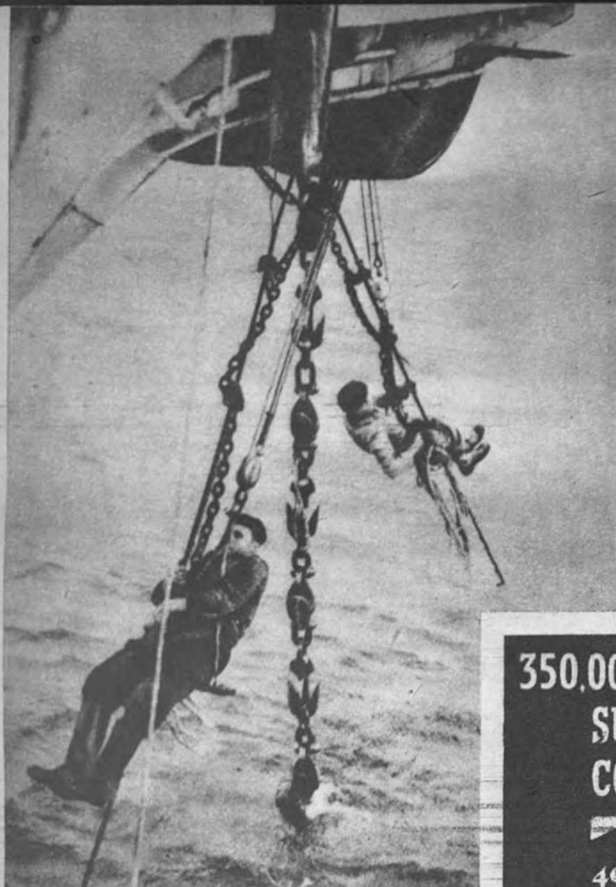
Primero hubo que localizar exactamente el punto en que estaba roto el cable. Después, buscar y hallar los dos extremos, extrayéndolos del fondo del mar para ser recompuestos
