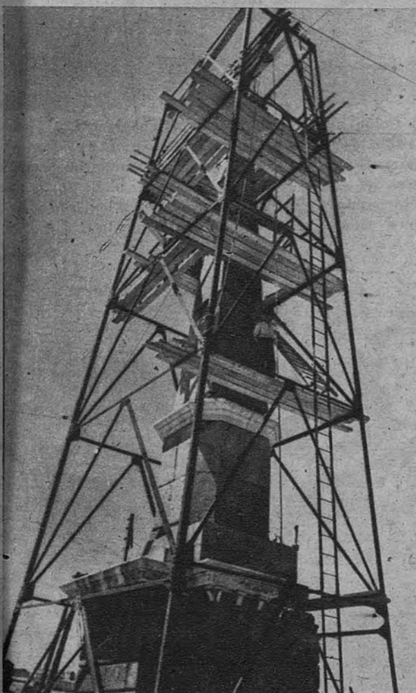
UNA PIRAMIDE CON ANDADOR. —No es solamente el aspecto del artilugio que rodea a la pirámide lo que sugiere el concepto de carretoncillo o andador. Es que precisamente el objeto de la estructura metálica que la recubre es cambiar su emplazamiento
