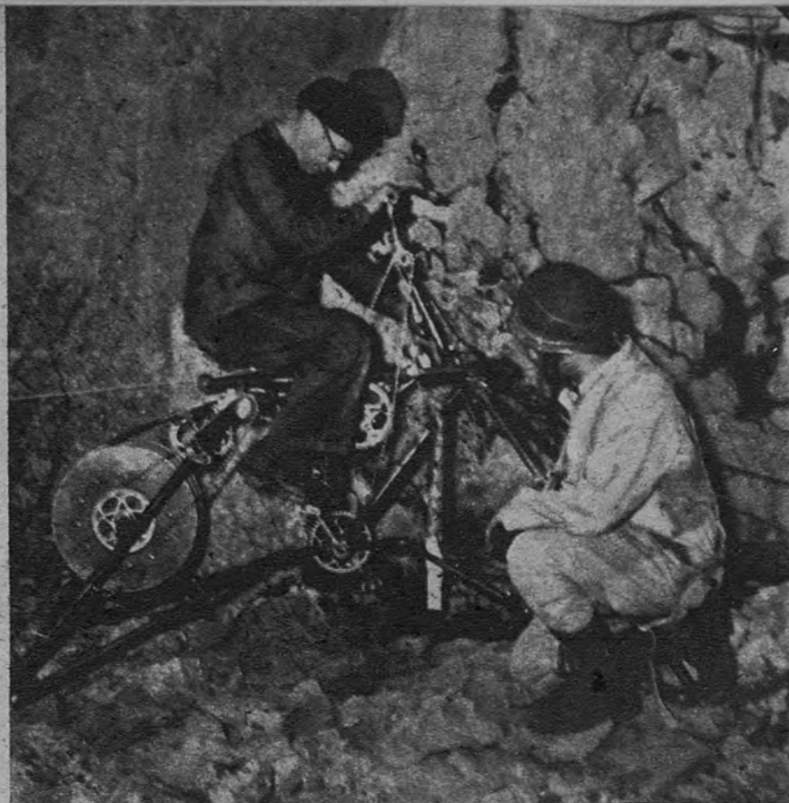
BUZOS DE TIERRA. —De modo semejante al procedimiento utilizado por los buzos, este mecanismo, movido a pedal, acciona los cables de la cabria, pieza fundamental en la investigación de las profundidades subterráneas
