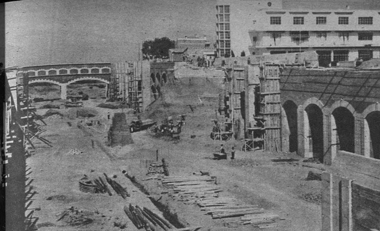
MOVIMIENTO DE TIERRAS. —Enormes cantidades de tierra han sido removidas en las obras de explanación para la autopista Madrid-Barajas, especialmente en este tramo, que cruza a desnivel la Ciudad Lineal
