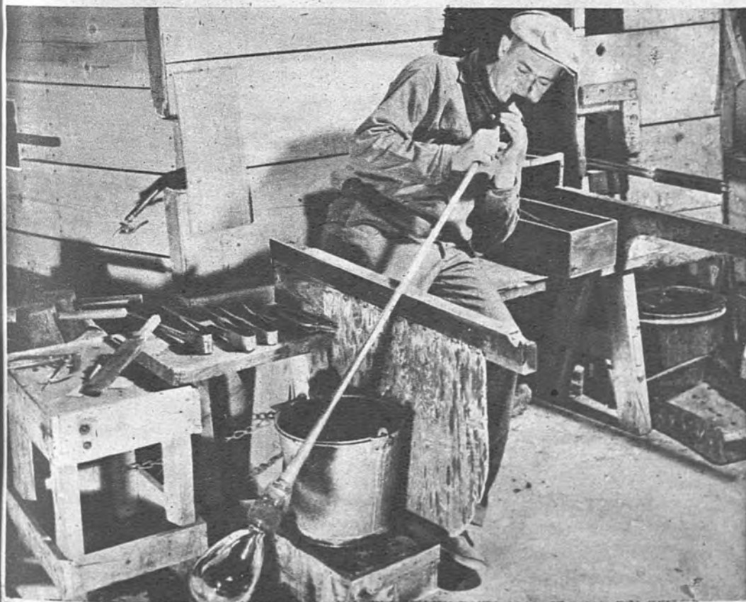
EL SOPLO TRADICIONAL. —La técnica moderna no ha podido desterrar todavía el sistema del soplo a través del tubo. Saber soplar es lo más difícil para el artífice del vidrio, y no hay máquina capaz de suplir los pulmones humanos
