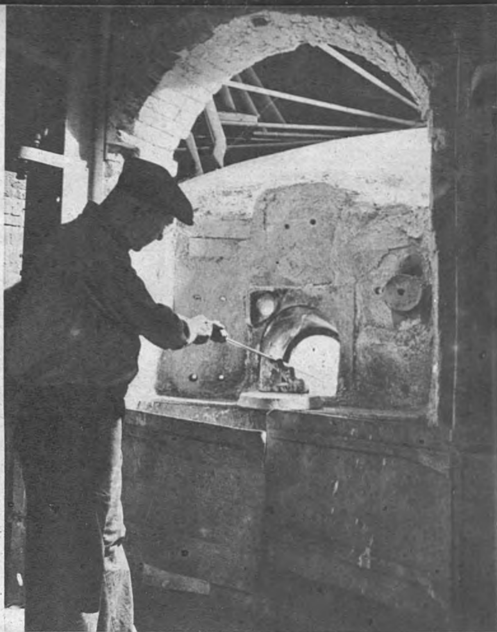
UNO DE LOS HORNOS. —En este horno se verifica la primera operación del cristal destinado a la confección de vasos y ánforas. En el museo llaman a este horno el «ojo glorioso», ellos sabrán por qué razón
