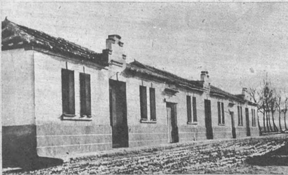
CASAS PARA MAESTROS. —En la casi totalidad de los pueblos de la provincia han sido construidas viviendas para maestros, cumpliendo así una de las más dignas consignas del Régimen
